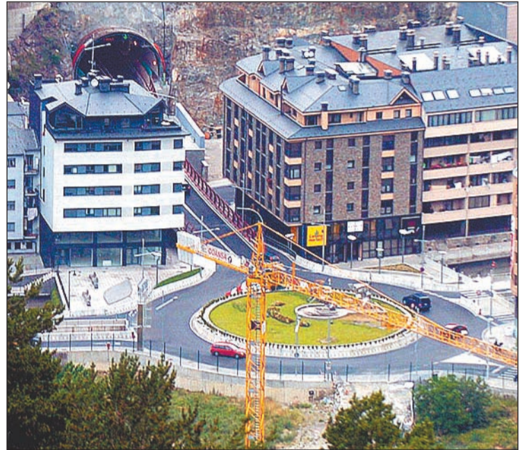
El túnel del Pont Pla ha descongestionat el trànsit.
